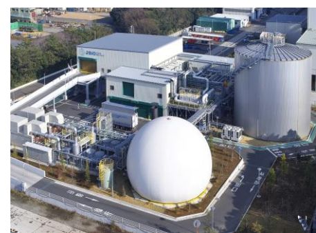
食品廃棄物 メタン発電施設 「Jバイオ横浜工場」
