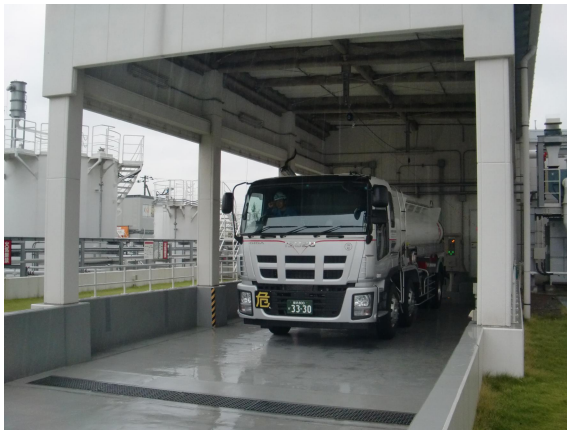
【ローリーヤード】
