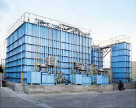
廃液受入タンク
