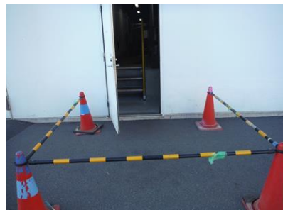
現場立入禁止措置(建屋外)
