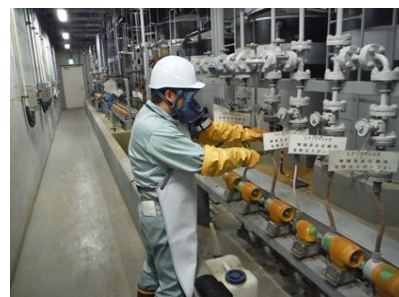
漏洩設備の停止作業
