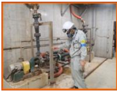
設備状況確認
