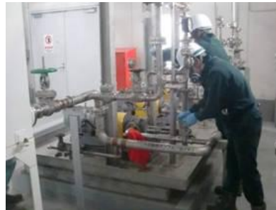
出入口弁の閉止操作
