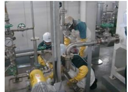
漏洩したPCBの回収作業
