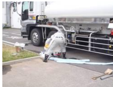
漏洩したPCBの回収作業
