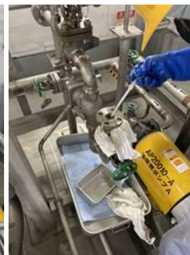
圧力計を外して残油を採取
