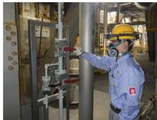
散水弁操作訓練
