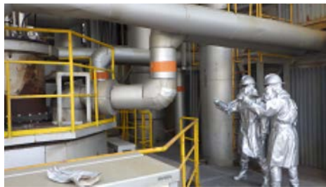
初期対応 (油回収・消火)
