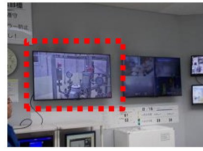
現場カメラによる対策本部での監視
