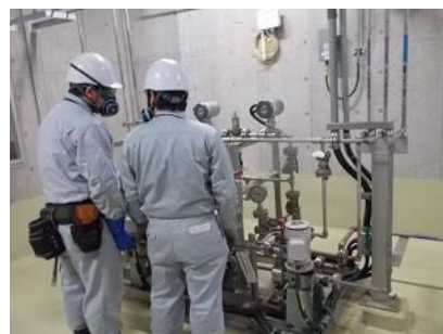
漏洩箇所の補修作業
