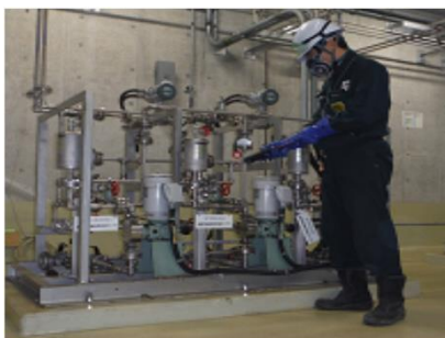
設備復旧後のリークチェック
